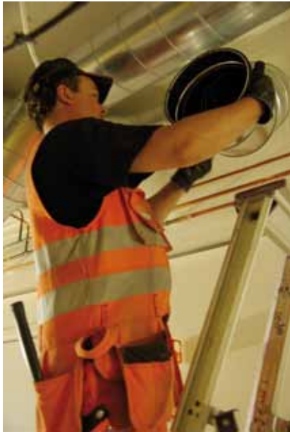
Kuudennen kerroksen remontissa uusittiin muun muassa ilmastointijärjestelmiä.
